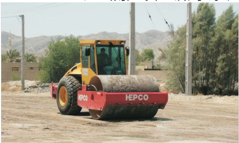
■ ماشین آلات در حال زیرسازی جهت آسفالت معابر و میادین بستک
